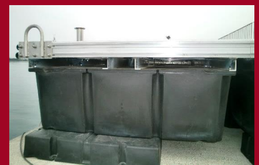
通常の棧橋や人道橋等では、このように鋼材と組み合わせてデッキを張っていきます。
