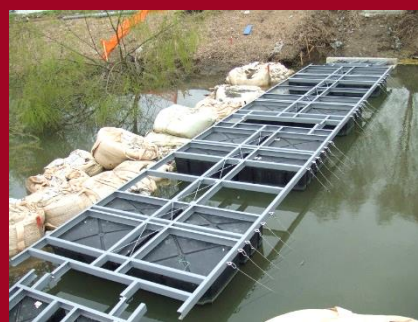
通常の棧橋や人道橋等では、このように鋼材と組み合わせてデッキを張っていきます。
