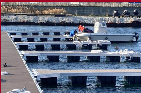
通常の棧橋や人道橋等では、このように鋼材と組み合わせてデッキを張っていきます。
