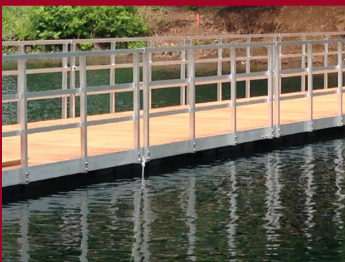
設置場所、ご希望の乾舷(水面からの高さ)に合わせ、専門の設計により浮力も計算します。
