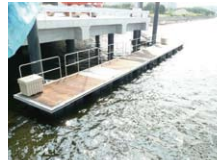
作業用浮棧橋 2.4m×10m、2.4m×7m を L 字に連結し、可変式階段で棧橋にアクセスします。
