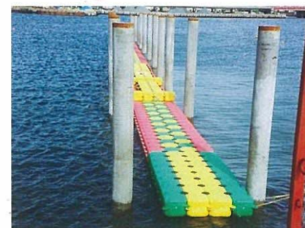
ボート係留 杭の間に設置し、ロープにて固定。工期短縮、低コスト。
